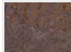
6503 rost stahl acier oxydé ruggine
